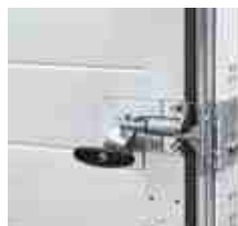
Ar roku vadāmiem vārtiem, kuros ir iebūvētas durvis, nav ārējā roktura. Tie tiek aizslēgti no iekšpuses.
